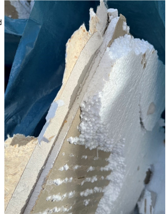
Abbildung 13: Rückbau von verklebten Platten, die kaum trennbar sind (Bild: Pichlmeier)
